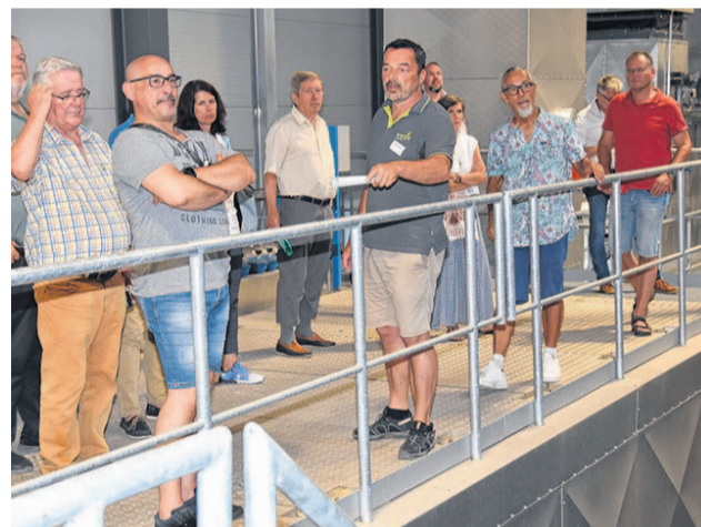
In der Energiezentrale erklärt der Chef Leitungsbau, Guido Reichmuth (Mitte), das Funktionieren der Anlage.
